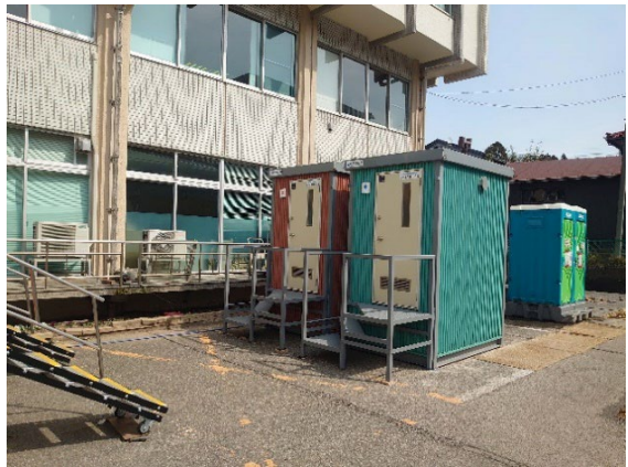
設置状況（門前会館）
