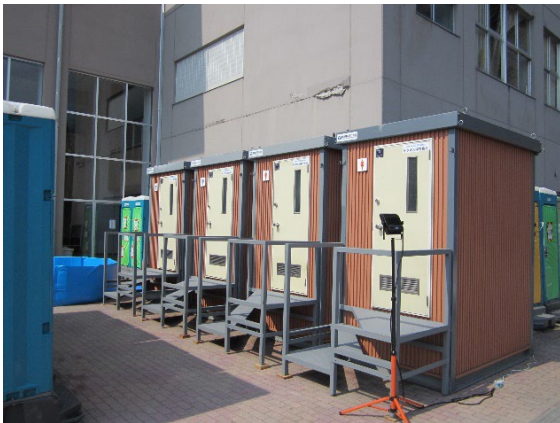
設置状況（門前中学校）
